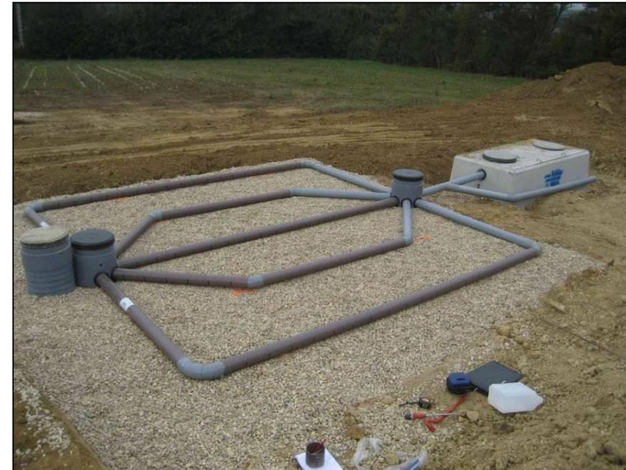
*Exemple de dispositif d'assainissement autonome (ADEME)*
