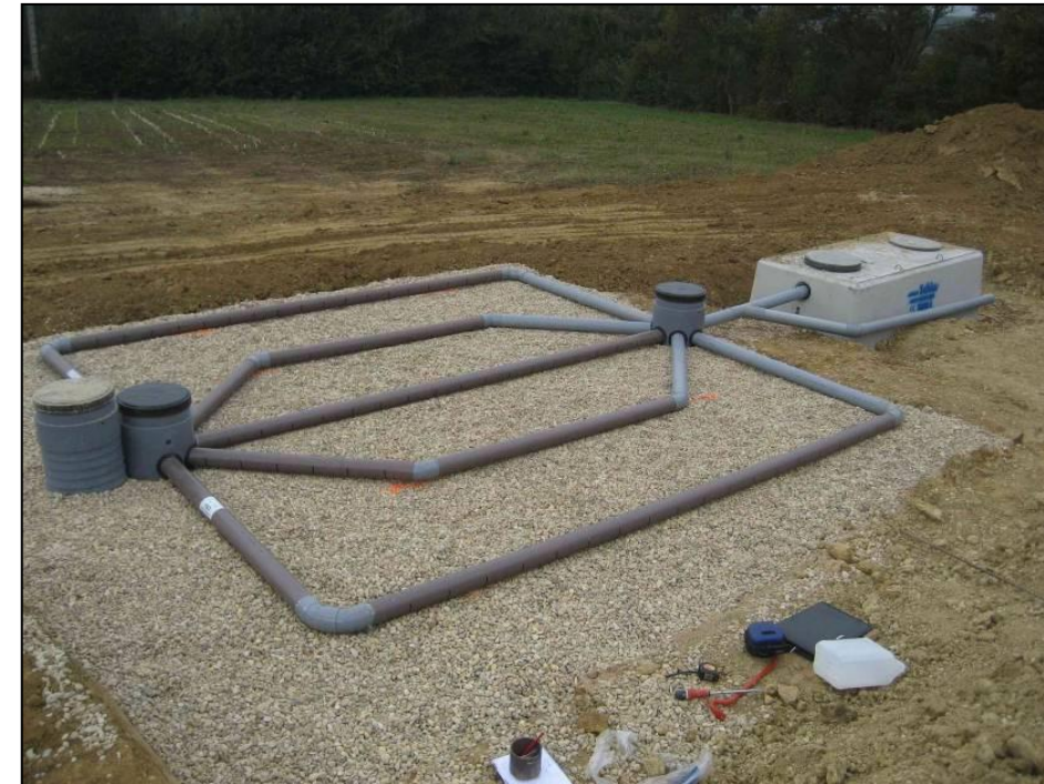
Exemples de dispositif d'assainissement autonome (ADEME)
