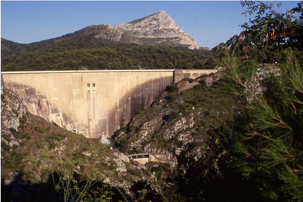
Le barrage de Bimont
