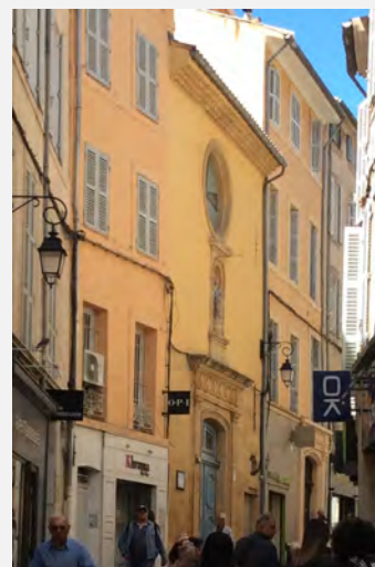
Vue rapprochée de la façade de l'ancienne chapelle de la Pureté, rue Bédarrides
