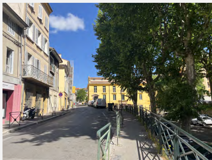
Vue rapprochée la façade du bâtiment des anciens thermes romains
