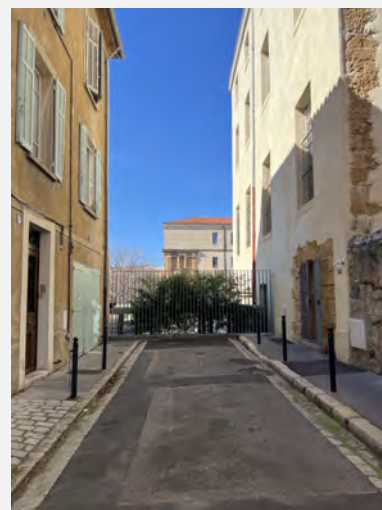
Vue rapprochée de l'ancienne entrée du couvent des Bénédictines et toiture de préau en premier plan
