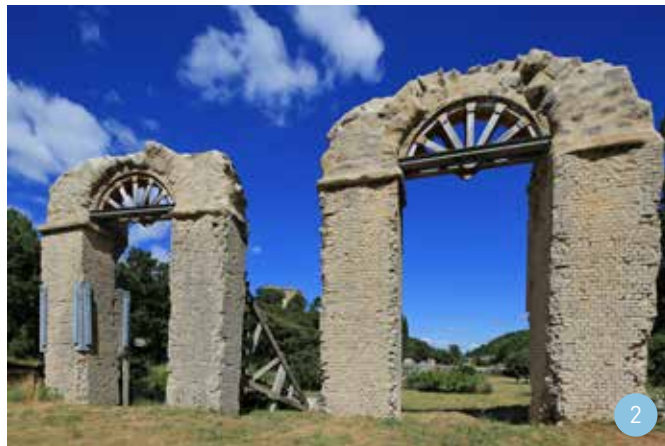
n°2 - Arches de l'aqueduc de la Traconnade, Meyrargues
