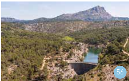
n°56 - Barrage Zola
