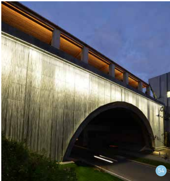
n°53 - Mur d'eau, avenue Max Juvénal
