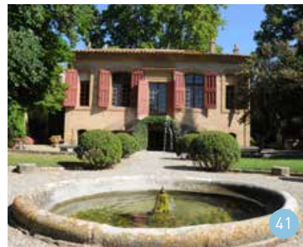
n°41 - Pavillon de Trimond - voir Lieux exceptionnellement ouverts
