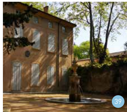
n°39 - Fontaine devant la bastide du Cézanne - lieu en cours de travaux non accessible
