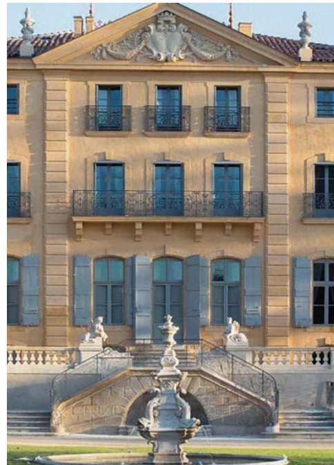
Chateau de Fonscolombe, Le Puy-Sainte-Réparate
