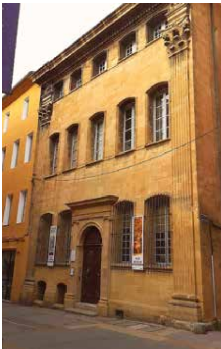
n°43 - Façade, hôtel de Simiane de Lacépède : traitement à refends, frontons alternés interrompus
