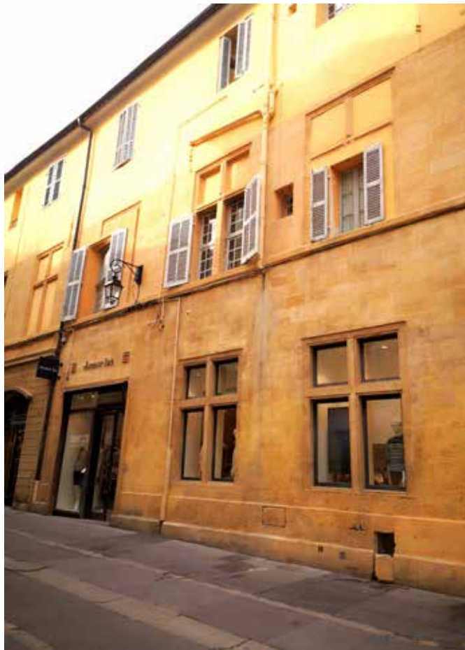
n°41 - Fenêtres à meneaux, face ouest, hôtel d'Albertas, rue Aude
