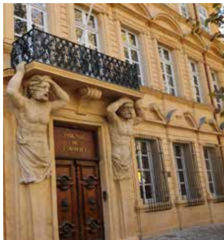
n°50 - Ordonnance classique, atlantes, hôtel Maurel de Pontevès, 1647-1650, 38 cours Mirabeau
