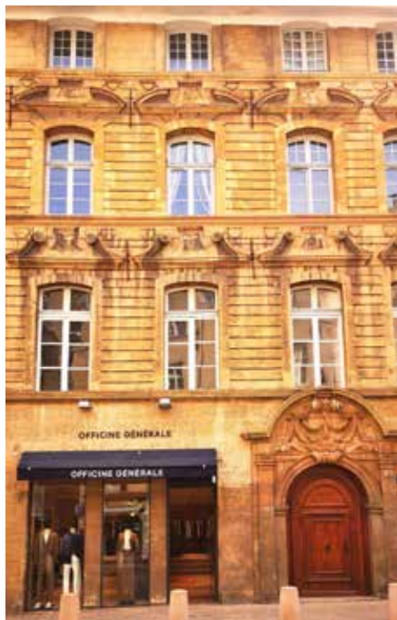
n°42 - Façade hôtel de Roquesante : traitement à refends, frontons interrompus, portail imposant sculpté
