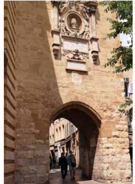
n°5 - Blocs au pied du Beffroi
