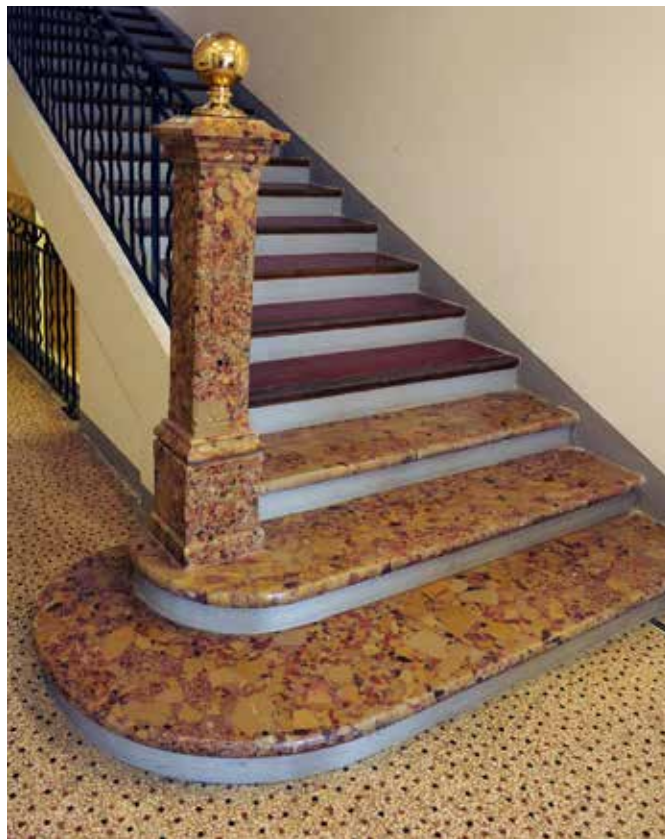
n°11 - Intérieur du Château du Tholonet : marches d'escalier et pilier en brèche d'Alep
