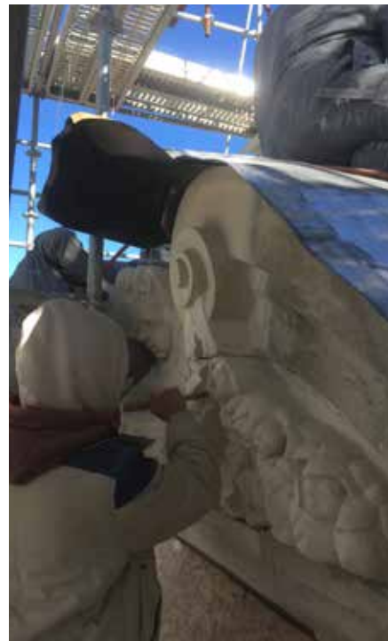
n°14 - tailleur de pierre : restauration d'un élément de décor de la façade de l'église de la Madeleine
