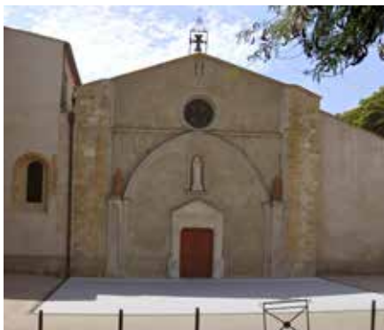
n°40 - Portail Renaissance, pierre de Calissane, chapelle de l'hôpital, avenue Philippe Solarie
