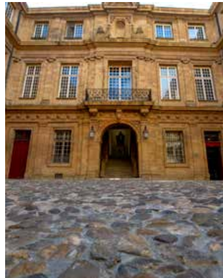
n°17 - Calade restaurée de la cour intérieure de l'Hôtel de ville en 2023
