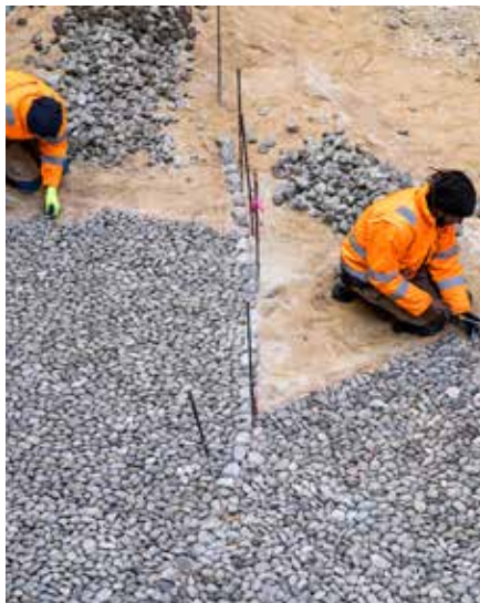
n°16 - Restauration de la calade de la cour de l'Hôtel de ville
