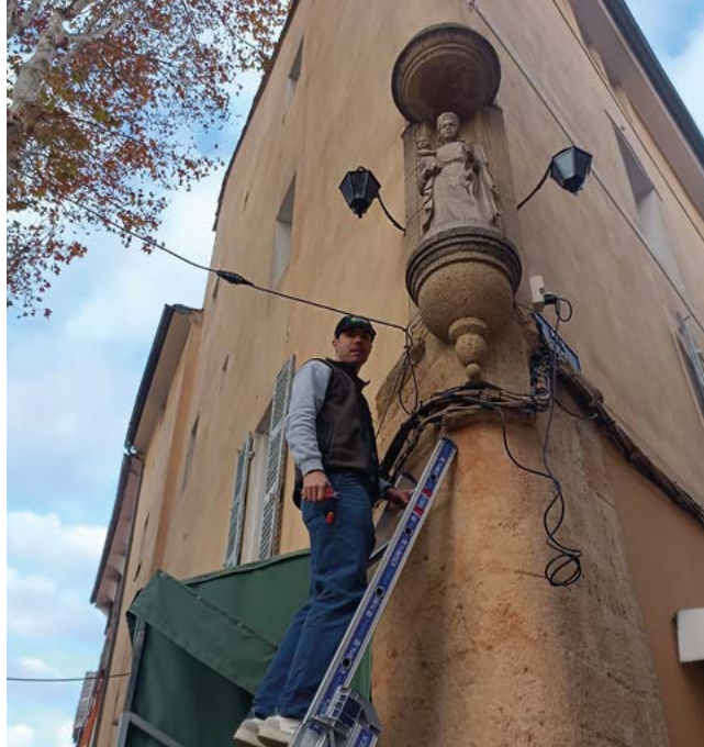
Restauration oratoire, rue d'Italie
