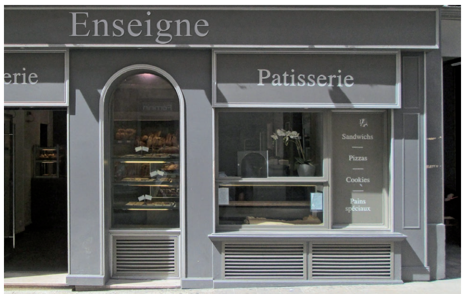
Exemple de climatiseur intégré dans une devanture commerciale, dissimulé derrière des ventelles.
