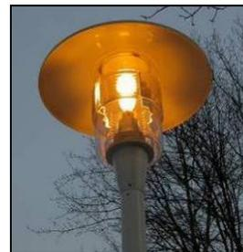
Photographie 57 : ampoule Sodium basse pression
