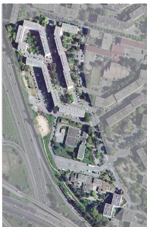
Site existant en 2021
