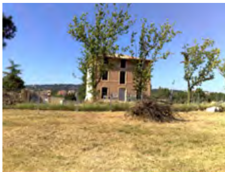
Le château de l'Horloge avant travaux
