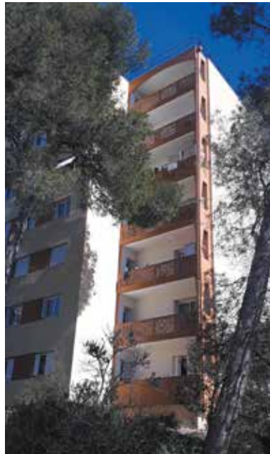
production chaleur, accompagnées d'un remplacement des radiateurs.
