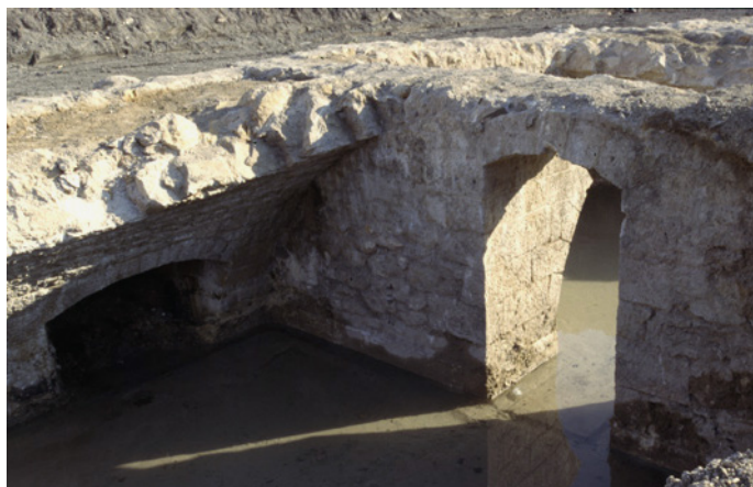
806 Détail des maçonneries de l'ancien bâtiment des voyageurs.
