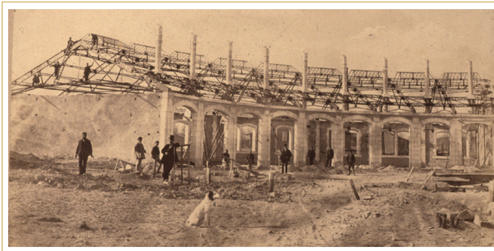
810 Construction de la remise des locomotives.
