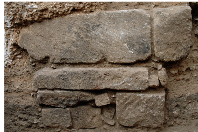
545 a et b Maçonneries de l'ensemble médiéval appuyé à l'enceinte antique.
