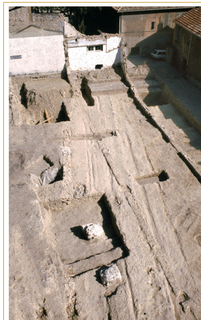
540 La route royale d'Avignon après sa réfection. Vue prise de puis l'ouest.
