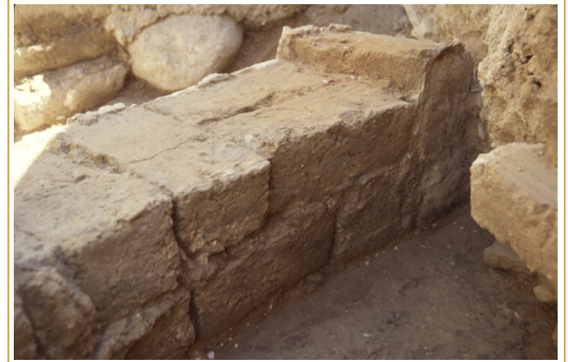
709 Détail de la maçonnerie en adobes de la pile centrale
