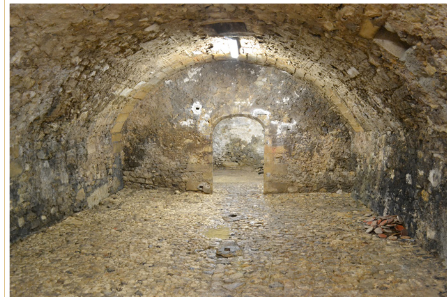
672 Vue d'une cave et de sa voûte en berceau surbaissée de l'Hôtel d'Oraison.
