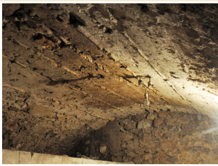
670 Détail d'une voûte et des traces de couchis formant le cintre.
