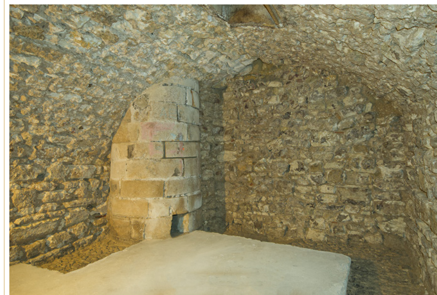
673 Vue de la gaine d'un puits public aménagée dans la cave du 8, rue Littera.
