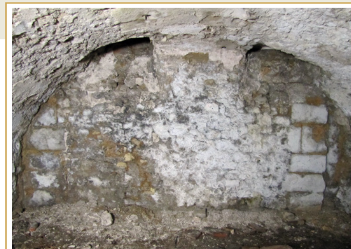
661 Fondations en pierre de taille de la façade dans la cave de l'aile orientale de l'hôtel Boyer d'Éguilles.
