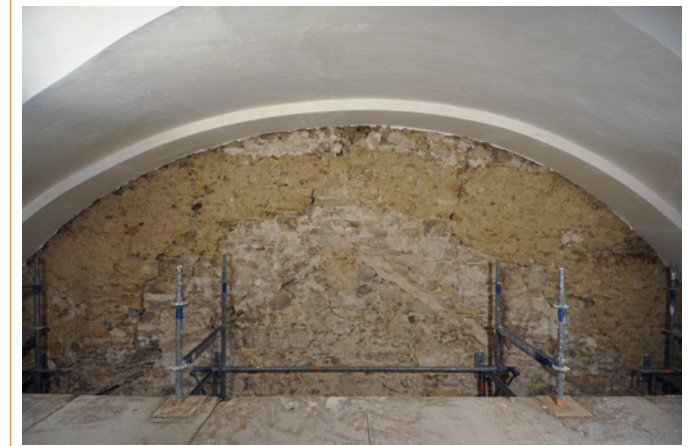
633 Revers de la façade occidentale (XV e s.). On y retrouve l'ancrage de la poutre faîtière, ainsi que les traces des deux versants de la toiture de l'église. Le pignon s'élevant au-dessus du toit est couronné par une base, peut-être le support d'une croix.
