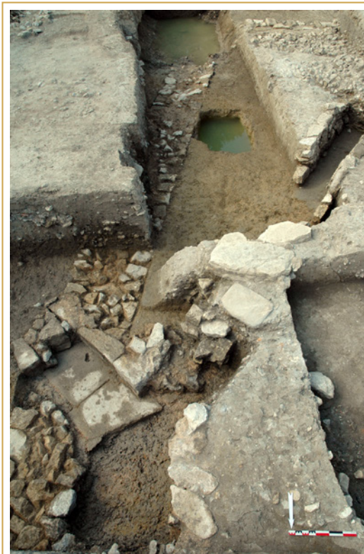
602 Croisement de deux canalisations réservant une conduite pour les eaux usées évacuées hors de l'enceinte conventuelle et une autre pour les eaux propres vers les jardins (cl. Mourad El Amouri)
