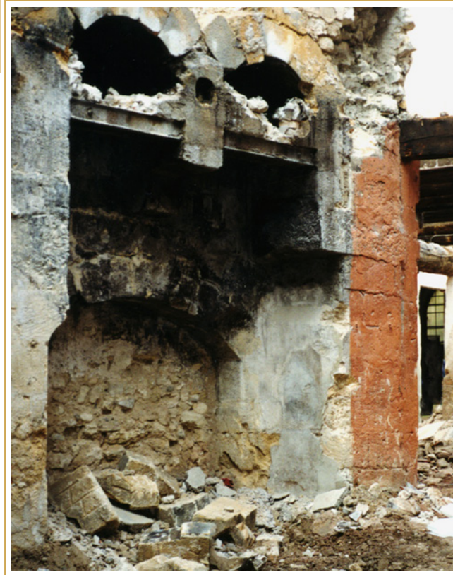
715 Le mur de chapelle, avant démolition en 2001.
