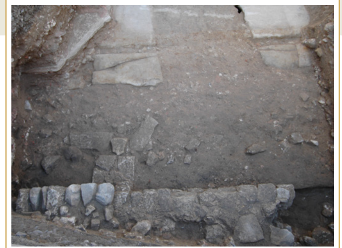
470 Dalles en cours de recouvrement par des recharges de ballast. Les ornières qui les sillonnaient sont déjà comblées.
