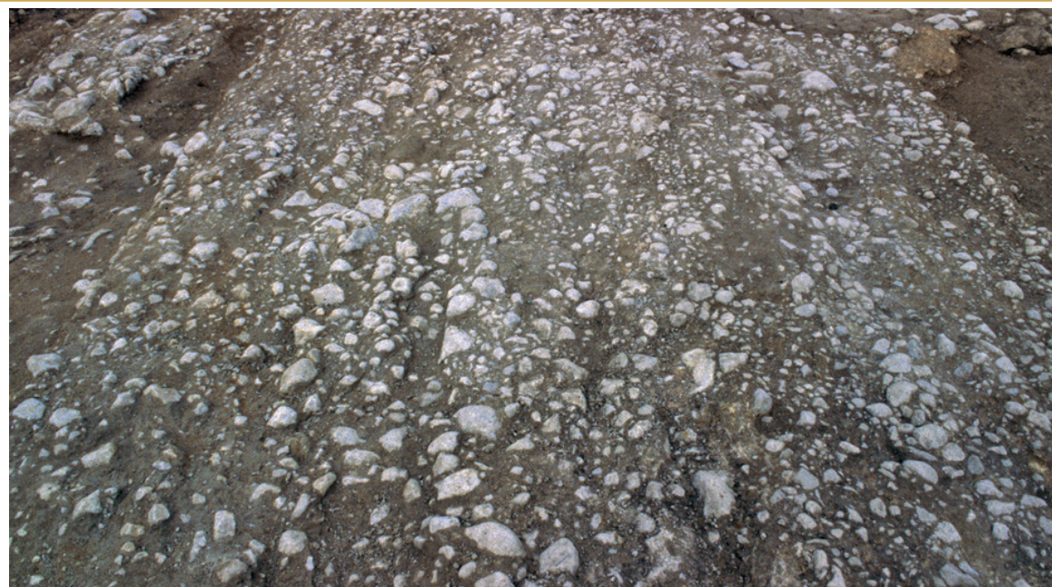
376 Détail du revêtement de la chaussée. Voie Aurélienne littorale, ZAC Sextius-Mirabeau, 1996.
