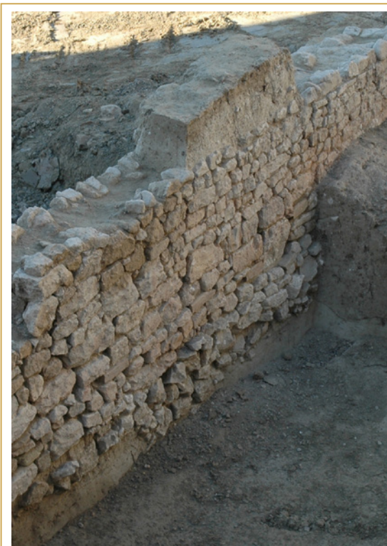
302b Vue générale montrant le mode de montage de la terre entre deux rangs de pierres
