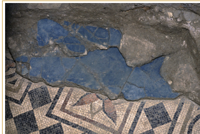
256 Peintures murales effondrées sur la mosaïque.
