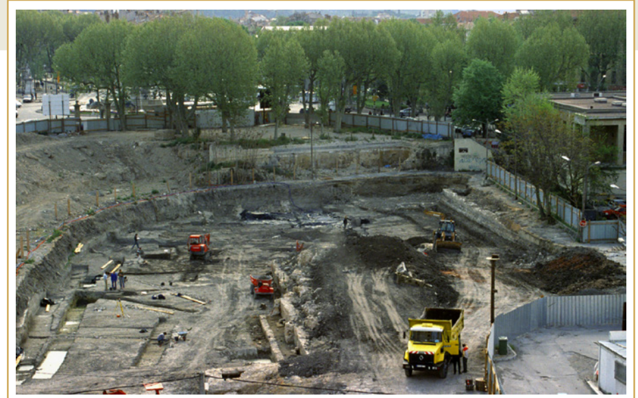
63 Vue aérienne du chantier de fouille réalisé à l'emplacement du Parking Rotonde en 2004
