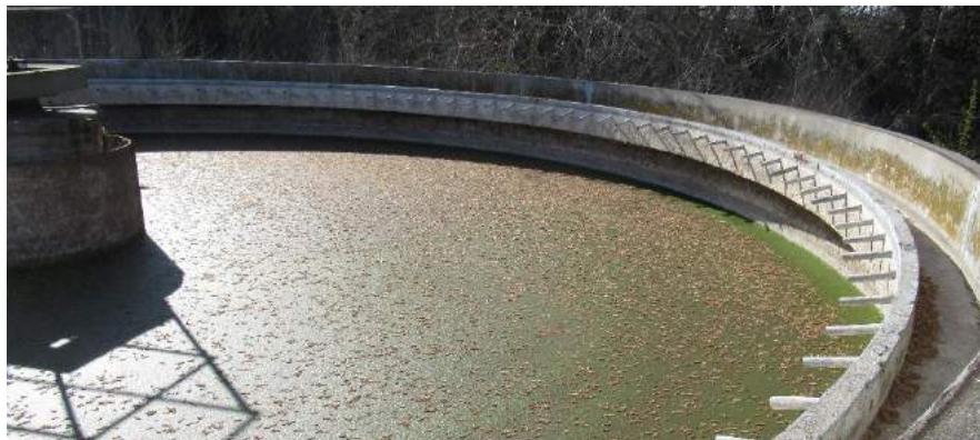
Figure 17. Bassin de l'ancienne station d'épuration. A noter le rebord empêchant la sortie de la faune une fois à l'intérieur. Photo sur site : Naturalia
