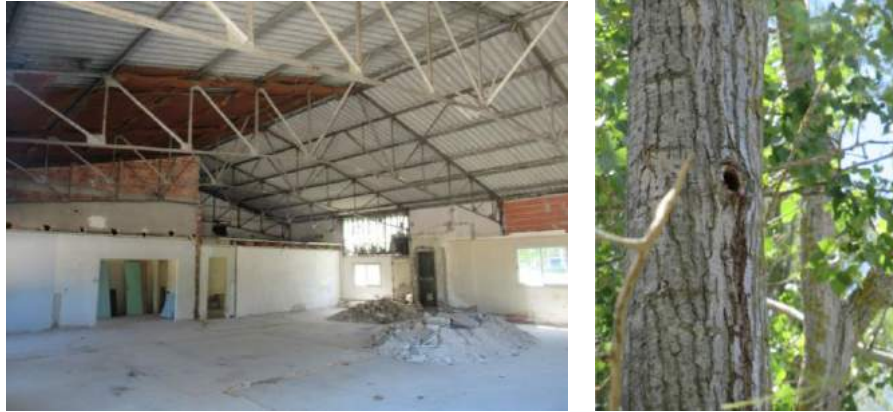
Figure 21. Bâtiment désaffecté inspecté (non favorable) et arbres à cavités
