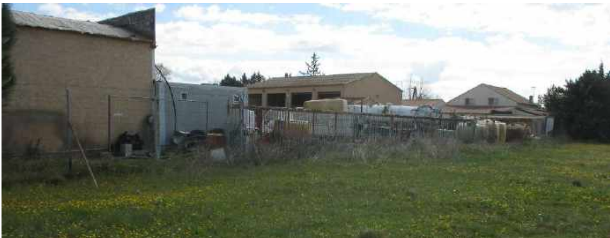
Figure 49 : Infrastructures de l'aérodrome
