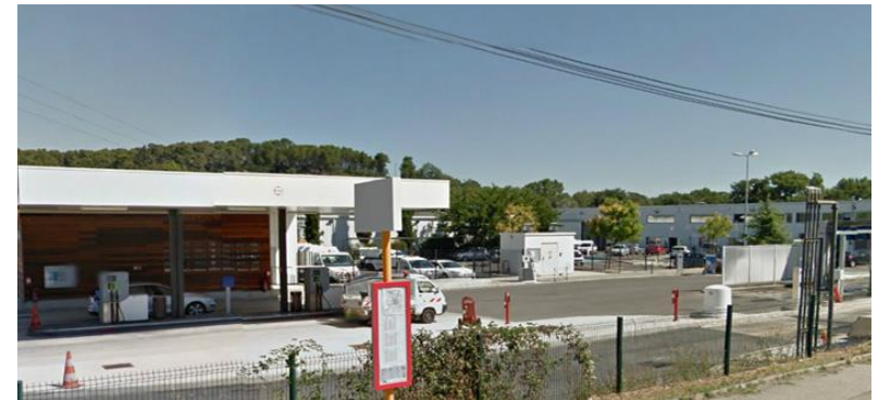
Centre de collecte des déchets
