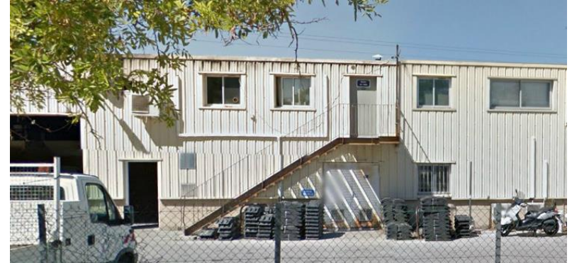
Bâtiments des services techniques municipaux
