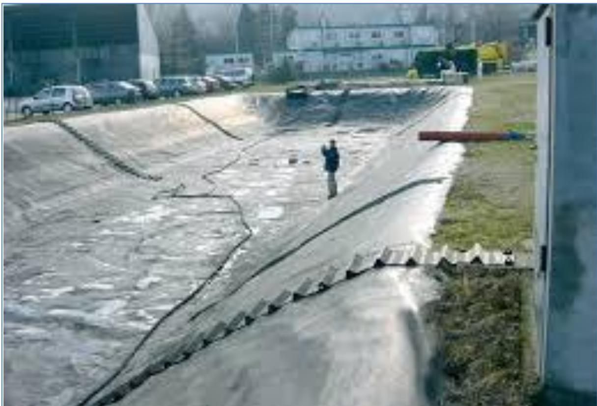
*Figure 24 : Escaliers en caoutchouc pour bassin de rétention (photo non contractuelle).*
