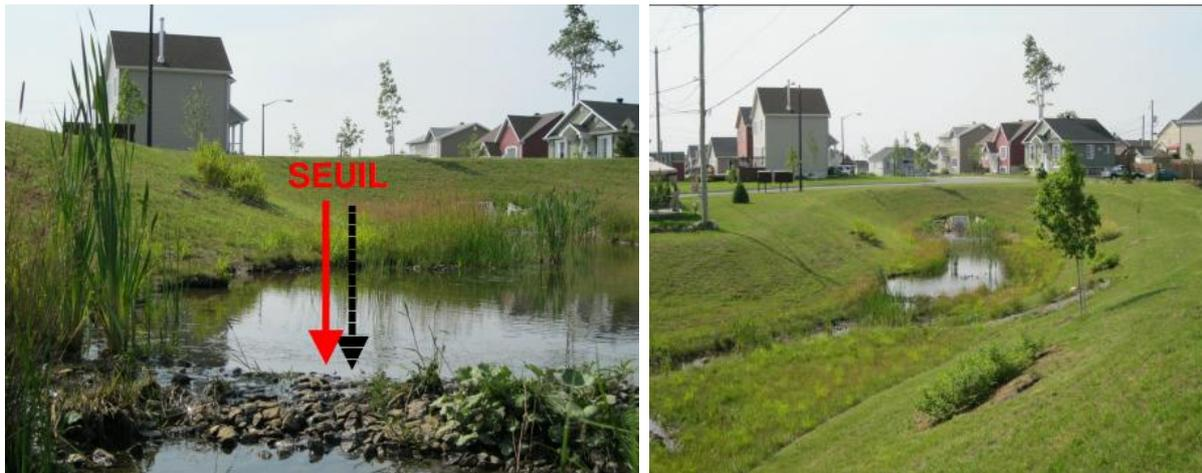
Figure 21: Illustration des seuils et d'un bassin de rétention (Source CAGEQ).
