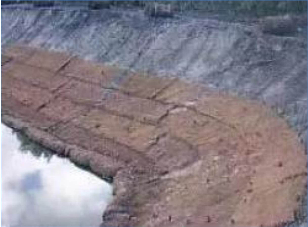
*Figure 25 : Géofilet en fibre de coco pour bassin de rétention (photo non contractuelle).*
