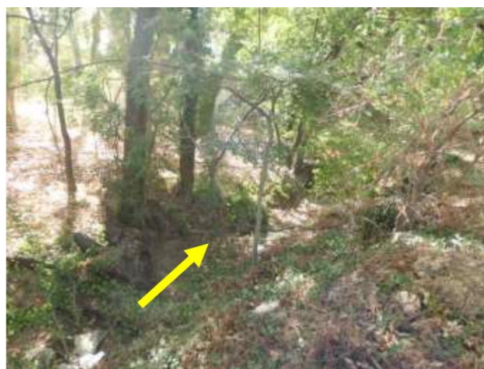
Photographie 10 : Fossé en bordure du chemin de Château Lafarge
