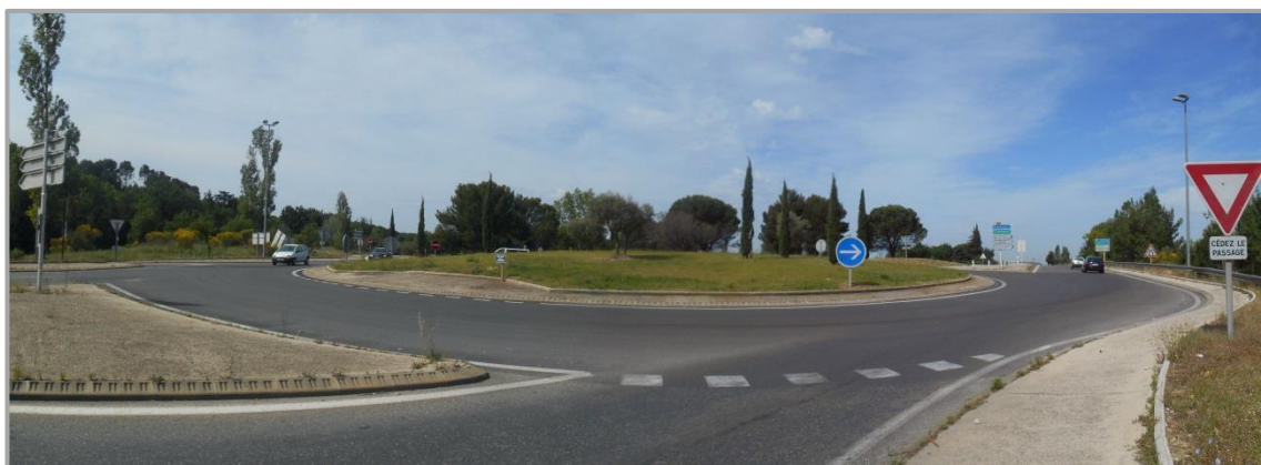
Photographie 1 : Rond-point Georges Couton à l'ouest – Vue vers Echangeur n°5 de l'A51
