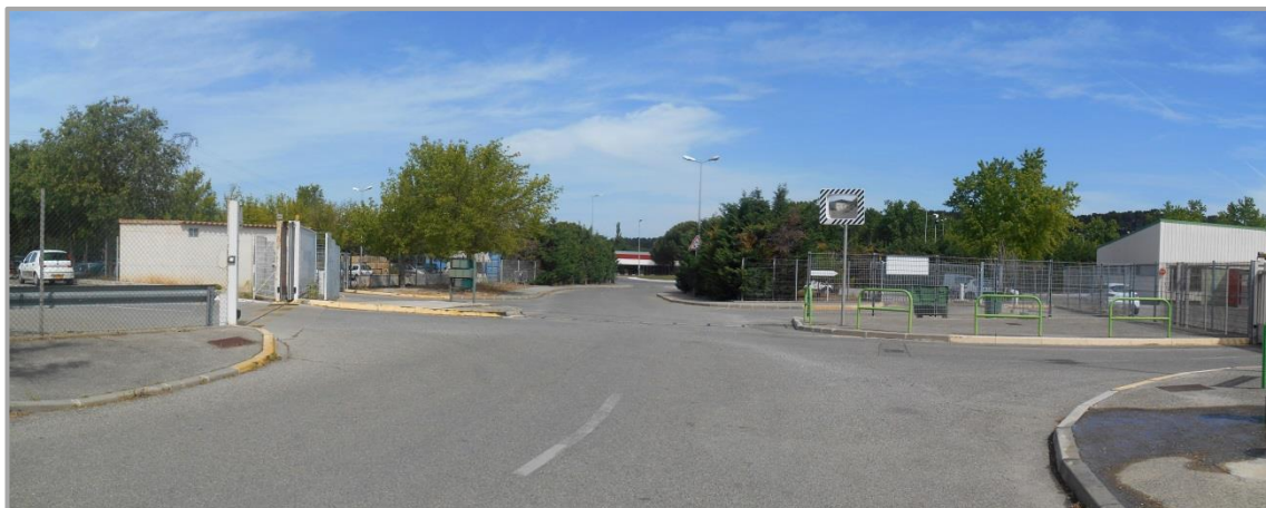
Photographie 42 : Voirie permettant l'accès aux différents services techniques de la zone
