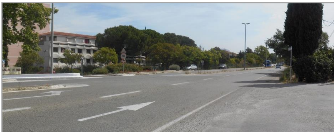
Photographie 3 : RD9 en direction d'Aix-en-Provence_ Vue vers le rond-point à l'est
