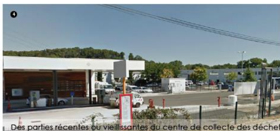
Des parties récentes ou vieillissantes du centre de collecte des déchets
