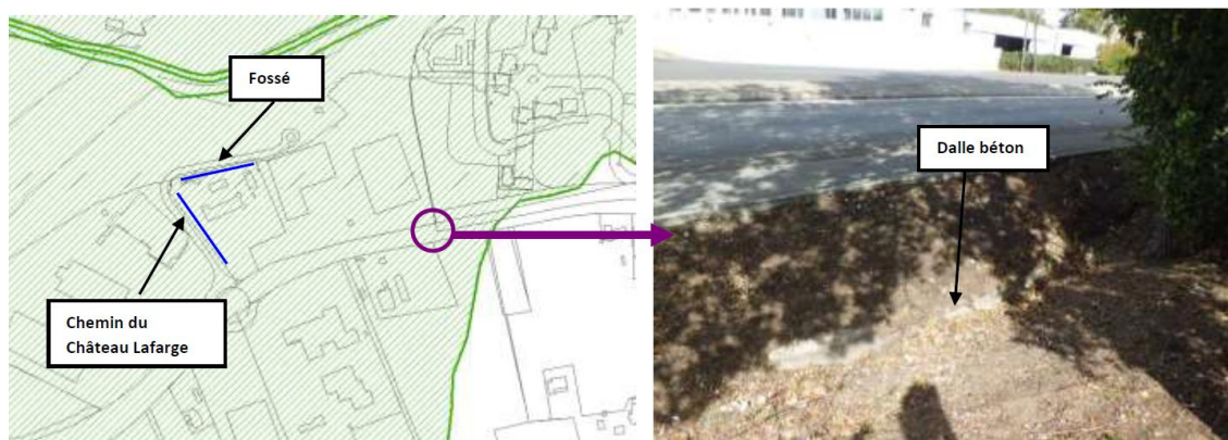
Figure 34 : Ancien ouvrage en amont de la Route des Milles
