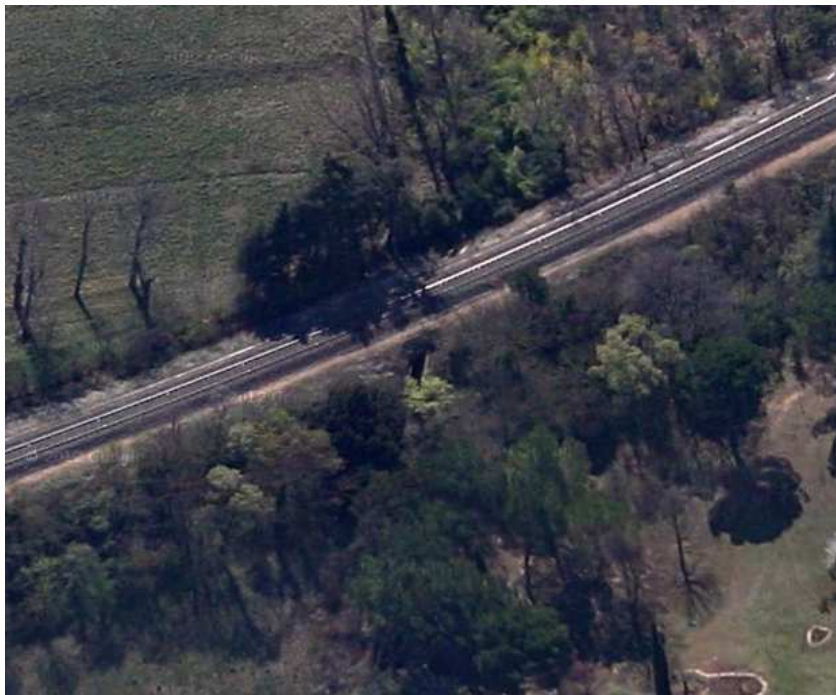
Vue aérienne de l'ouvrage depuis l'aval
