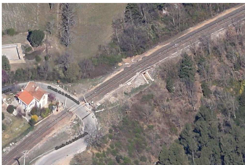
Vue aérienne de l'ouvrage depuis l'amont
