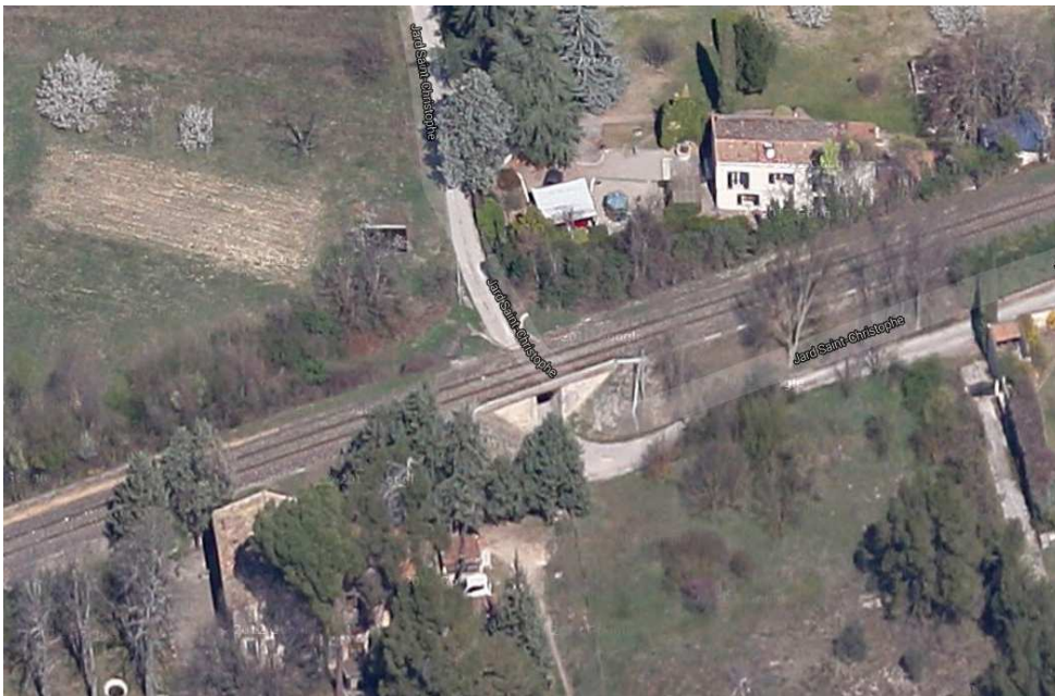
Vue aérienne de l'ouvrage depuis l'amont
