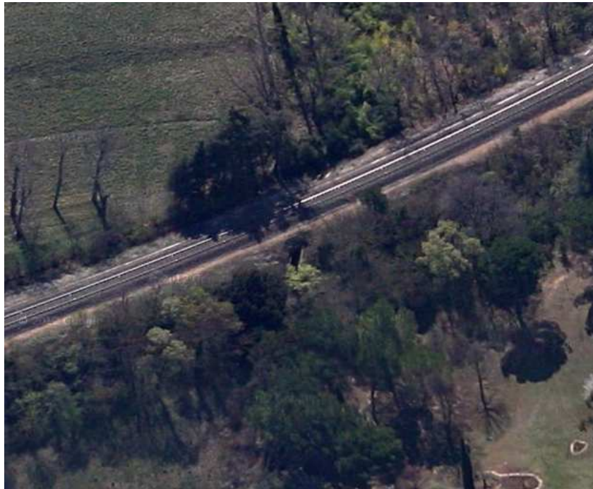
Vue aérienne de l'ouvrage depuis l'aval
