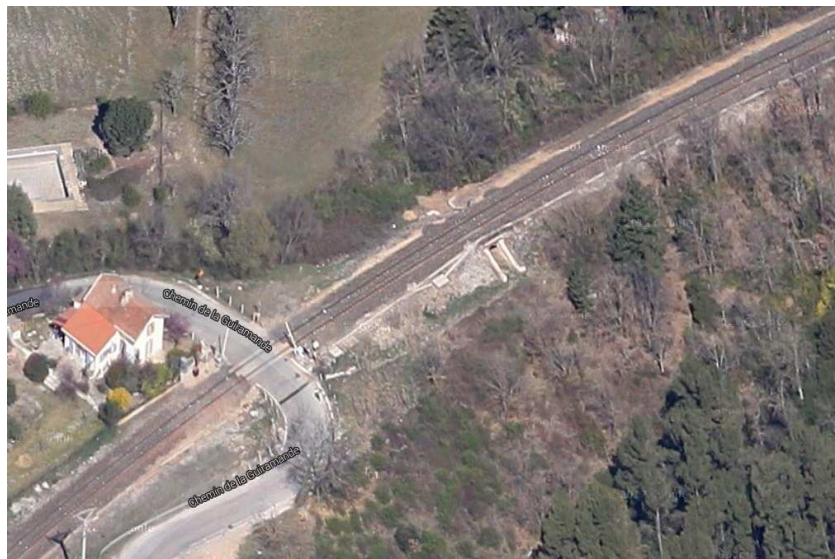
Vue aérienne de l'ouvrage depuis l'amont
